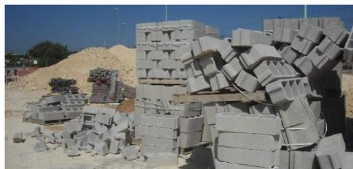
Rotura de material por acopio indebido
